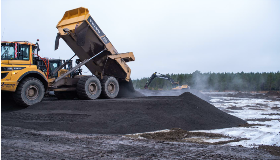
Figur 2 Utläggning av slaggrus vid Umeå Energi med dumper (Foto: Anders Friberg).
