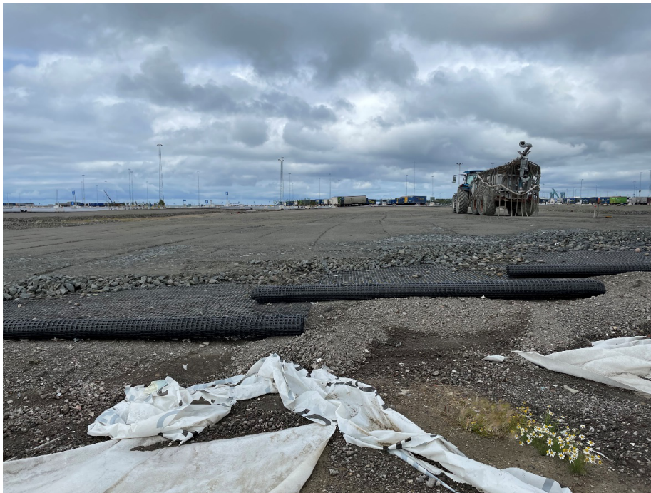
Figur 5 Utlagt slaggrus i Trelleborg under materialseparerande skikt täckt av bergkross (i bakgrunden syns fordonet som användes för bevattning av slaggrusytan, foto: Martijn van Praagh).
