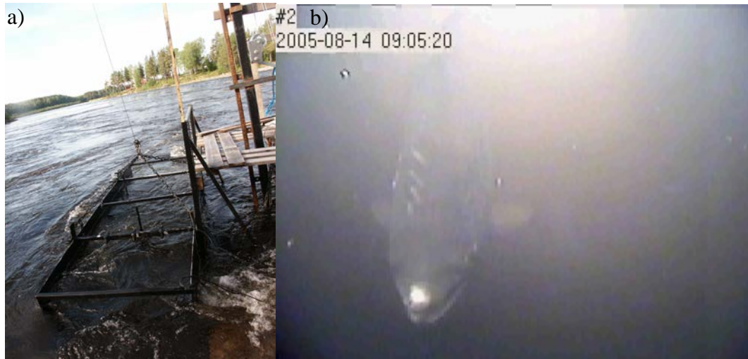
Figur 10: Lockvattenanordning vid Sikfors kraftstation. Anordningen är placerad i utloppet från turbinerna (a), bild (b) visar en fisk som simmar igenom anordningen.
