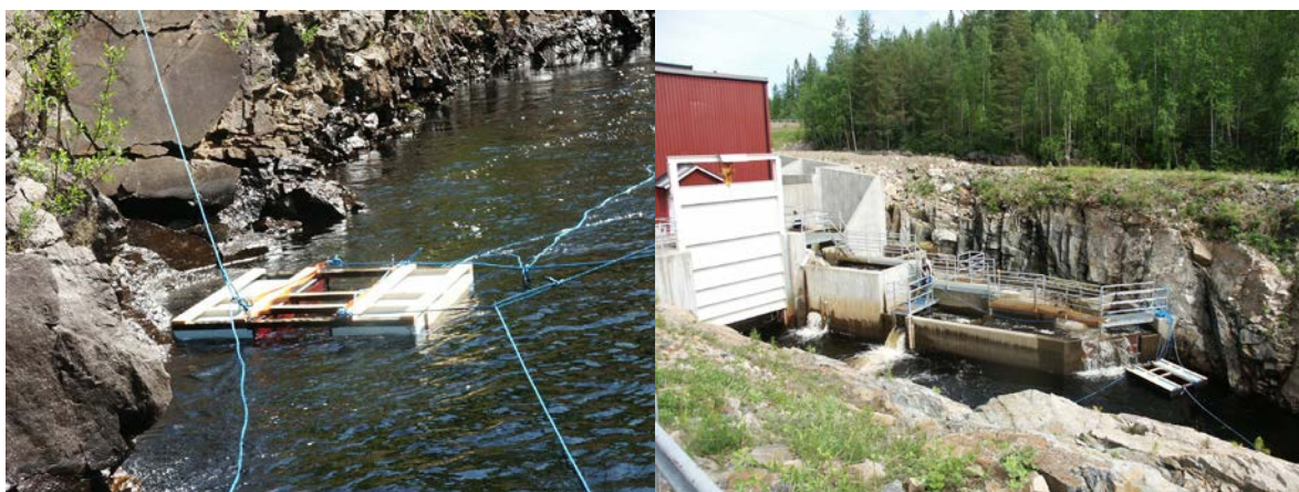
Figur 9: Flytande lockvattenanordning vid Hednäs kraftstation i Åbyälven.
