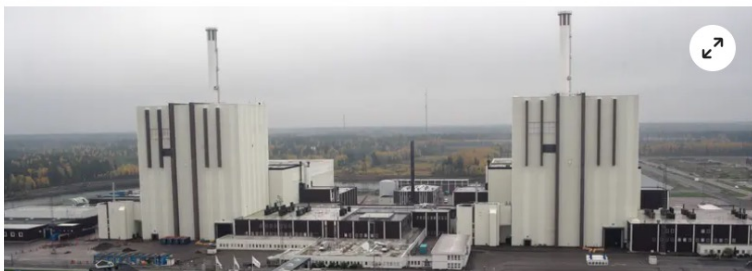
Både Forsmark 1 och 2 drabbades av strömavbrottet och kopplades bort från elnätet. Foto: Fredrik Sandberg / TT
